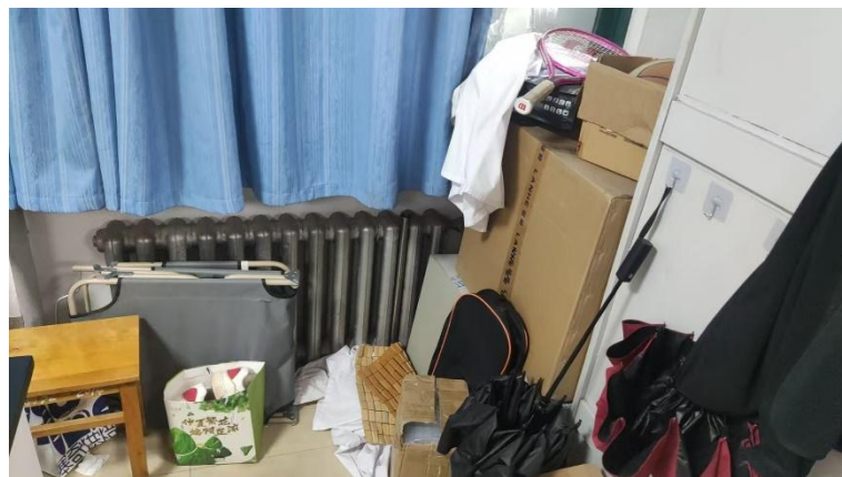
格致楼 1030：实验室卫生差，物品摆放杂乱
