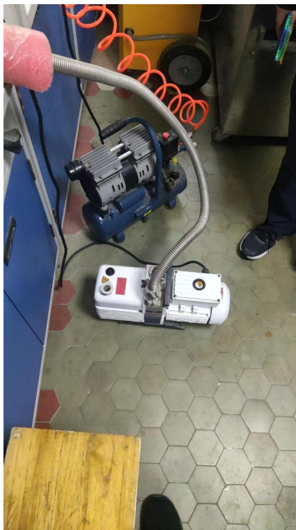
格致楼 2013: 机械泵需要安置排气管
