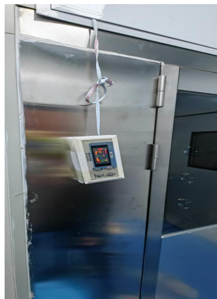
格致楼 1016：空调插线板不规范、门口控制盒没有固定
