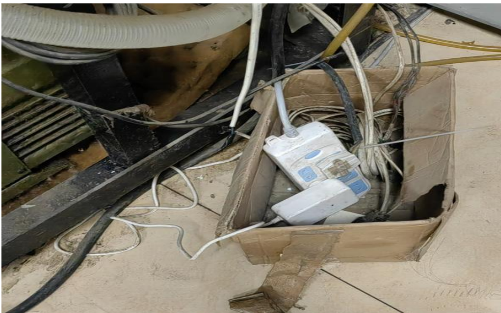
格致楼 1016：空调插线板不规范、门口控制盒没有固定
