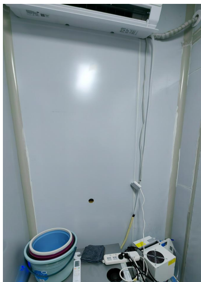
格致楼 1016：空调插线板不规范、门口控制盒没有固定
